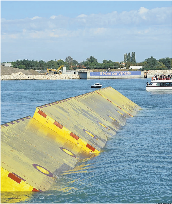
Negli ultimi test, problemi nell'innalzamento delle paratoie
